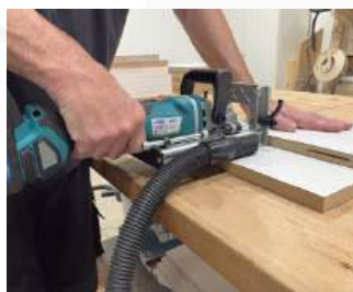
Montagem em esquadro
