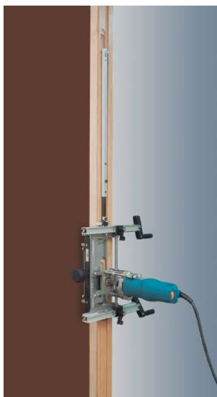
Realização do segundo rasgo no aro.
